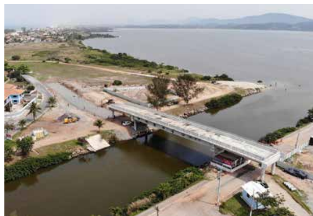
Construção da ponte de Ponta Negra, Maricá (RJ)
