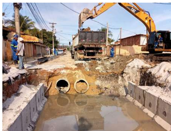
Drenagem, pavimentação e obras de arte em Saquarema (RJ)
