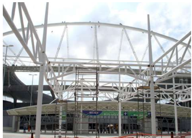
Passarela de acesso ao Estádio do Engenhão (RJ) PASSARELA DE ACESSO AO ESTÁDIO DO ENGENHÃO (RJ)
