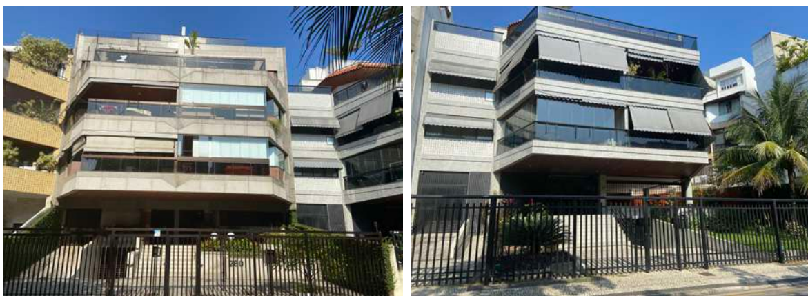
Prédios residenciais à Rua Afonso Taunay, nºs 310 e 350, Barra da Tijuca (RJ)
