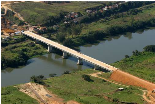
Construção do acesso Sul/Norte da Rodovia BR-116/RJ, contorno da Cidade de Resende (RJ)
