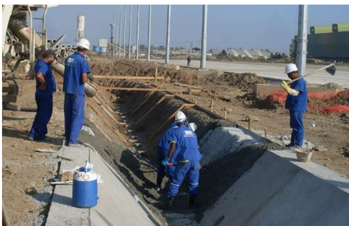
TKCSA/RJ - Execução de construção civil para canais de drenagem
