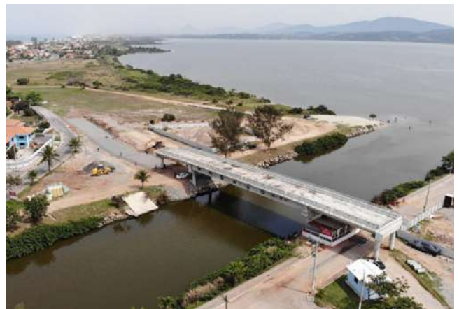
Construção da ponte de Ponta Negra, Maricá (RJ)
