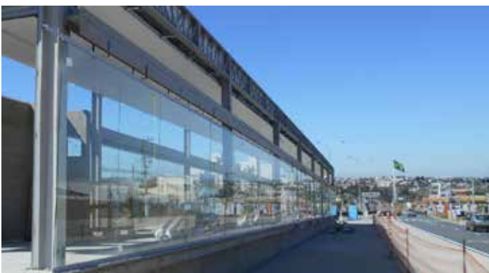
Implantação do BRT de Campinas (SP) IMPLEMENTATION OF THE BRT IN CAMPINAS (SP)
