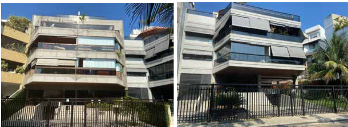
Prédios residenciais à Rua Afonso Taunay, nos 310 e 350, Barra da Tijuca (RJ)
