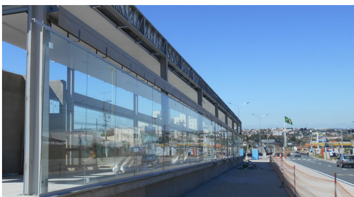
Implantação do BRT de Campinas (SP)
