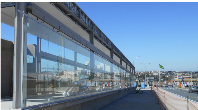
Implantação do BRT de Campinas (SP)
