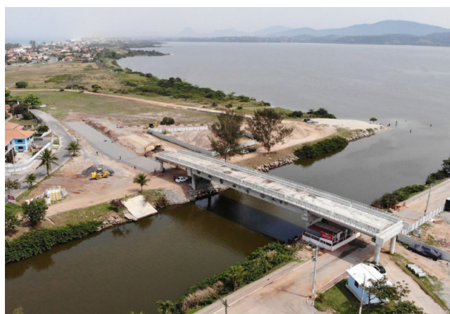
Construção das alças da Ponte de Ponta Negra, Maricá (RJ)
